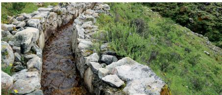
**Canales de infiltración:** transportan el agua hacia las laderas de infiltración, permitiendo de manera simultánea la infiltración hacia el subsuelo.
