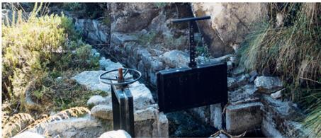
**Canales de enrutamiento:** estructuras de dos tipos: (1) canales largos que desvían los caudales de quebradas hacia canales de infiltración y laderas, y (2) canales cortos que direccionan el agua excedente hacia balsas u otros cursos de agua aguas abajo.
