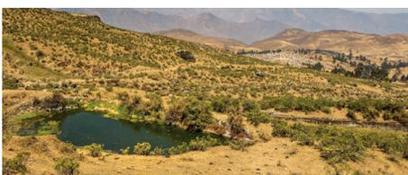
**Balsas:** cuerpos de agua pequeños (cada uno con un volumen aproximado de 300 m<sup>3</sup>) que se emplean para regular el flujo de agua a través del sistema de infiltración. Sirven para dos propósitos: (1) almacenar agua para el acceso directo, (2) e incrementar aún más la infiltración de agua subsuperficial.
