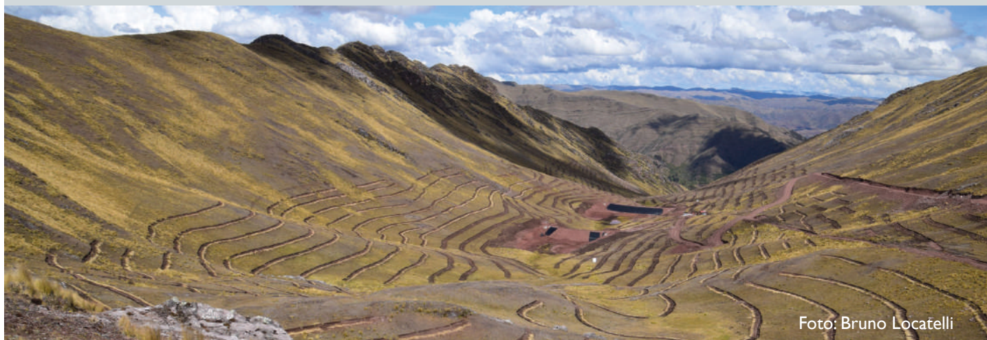
Zanjas de infiltración en Can Can, de la cuenca de Piuray-Ccorimarca, en la región Cusco, Perú.
